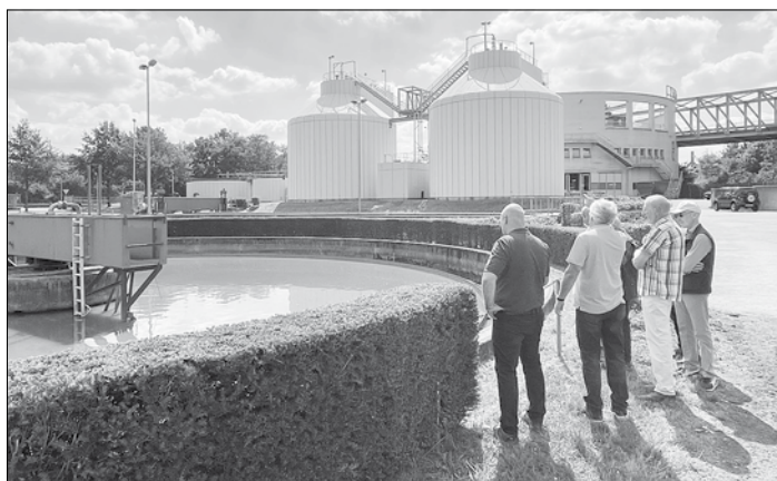
Betriebsingenieur Uwe Woll und EVS-Geschäftsführer Holger Schmitt führen die erste Gruppe mit Bürgermeister Christof Sellen durch die Anlage Fotos: Stadt Völklingen
