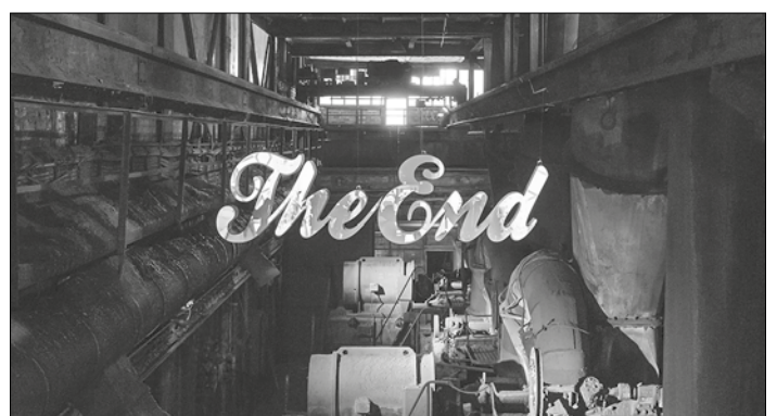
Ort des Kunstwerks: Ventilatorenhalle Weltkulturerbe Völklinger Hütte
