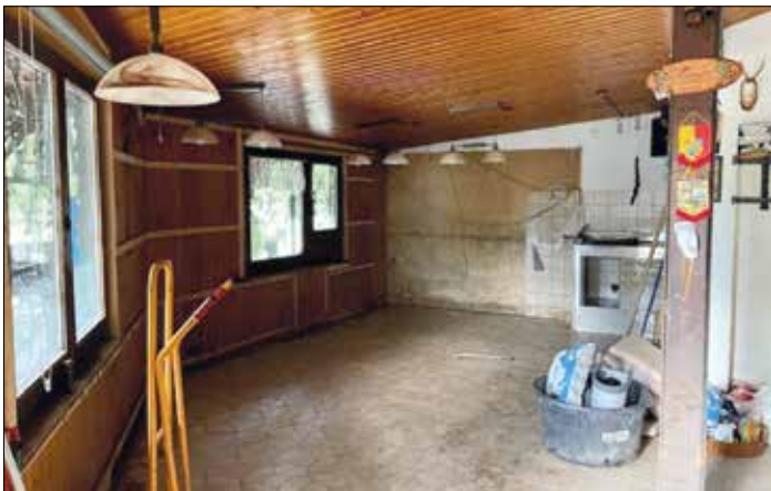
Foto vom 21.05.24 – Hütte im „Rohbauzustand“
