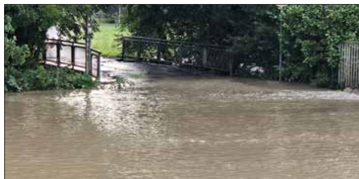
Wassermassen an der Brücke der „Pferdeschwemme“
