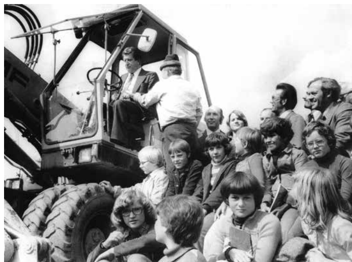
Eine Gemeinde im Aufbau. Hier Kulturminister Werner Scherer (1928-1985) im Bagger. Mit im Bild rechts oben Bürgermeister Theo Carlen und der Ommersheimer Ortsvorsteher Albert Uth (1932-2016).
