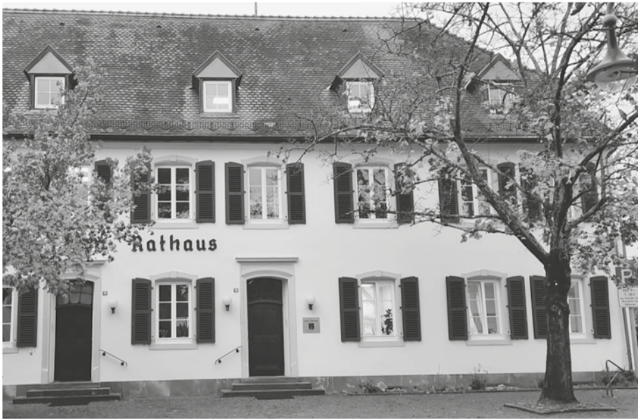
Straßenansicht historisches Rathaus nach der Sanierung
