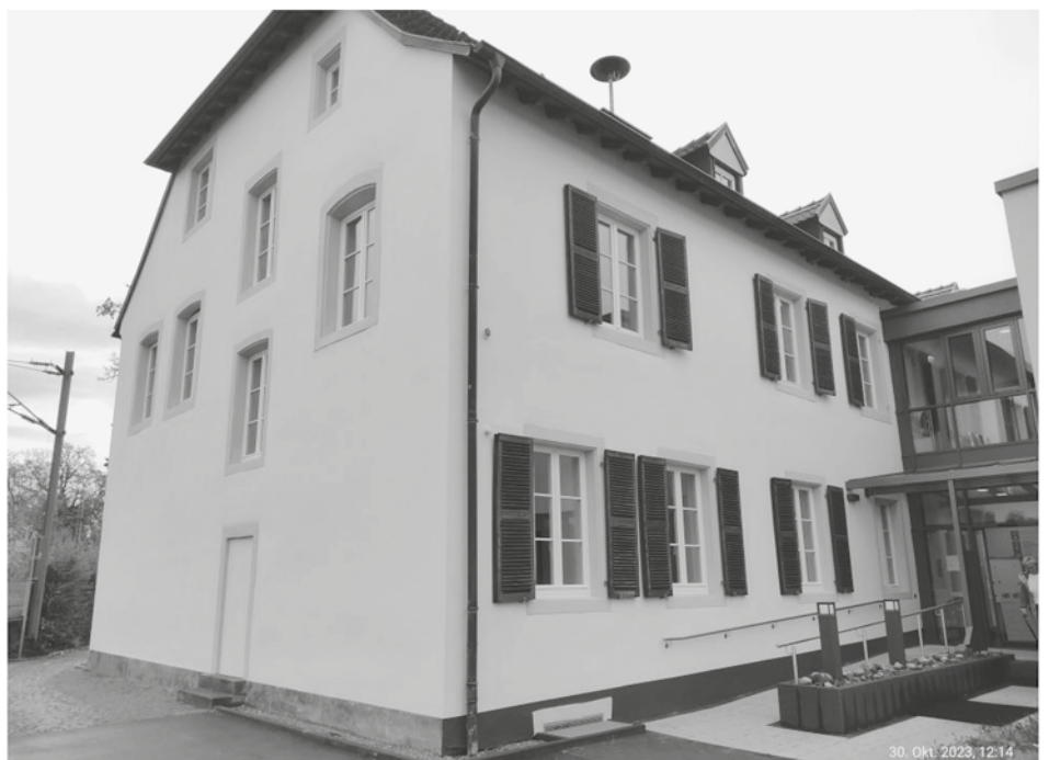
Sanierter Giebel und barrierefreier Eingang über den Rathausanbau
