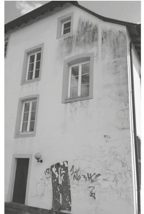
Giebel vor der Sanierung
