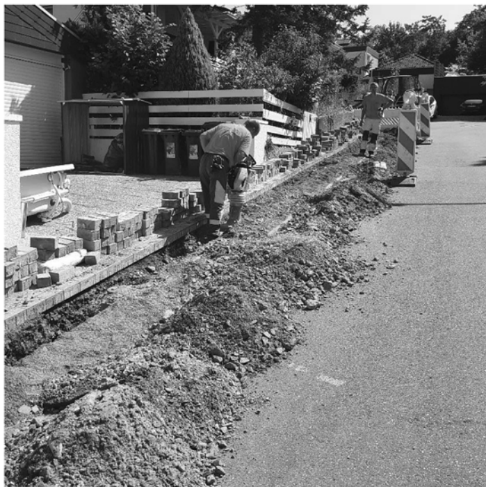
Beginn der Bauarbeiten
