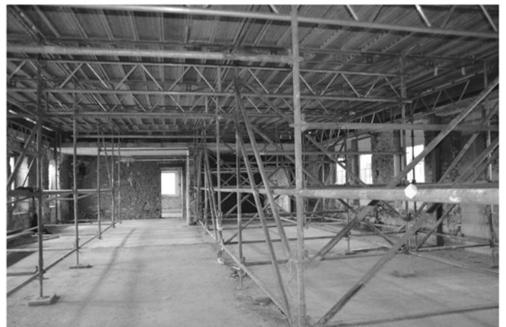
Blick in das Dachgeschoss
