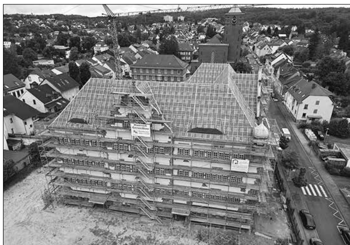
Die Ludwigschule erhält eine neue Dachbedeckung
