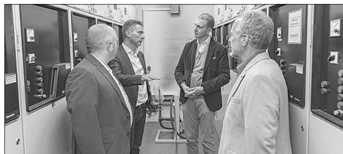
Jürgen Bach, Geschäftsführer der Biosphären-Stadtwerke St. Ingbert GmbH (hinten links), und Oberbürgermeister Dr. Ulli Meyer (hinten rechts) machten sich zusammen mit Prokurist Thomas Klein (re.) und Reiner Grund, Techn. Leiter Strom (li.) ein Bild vor Ort in der Trafo-Station. Foto: Thomas Bastuck
