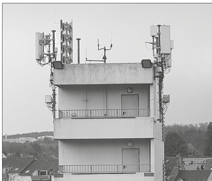
Auf dem Schlauchturm löst eine elektronische Hochleistungssirene eine Motorsirene aus den 60-er Jahren ab.
