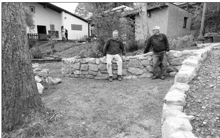
Unser Foto zeigt Sigg, Davor, vor der fertigen Natursteinmauer.
